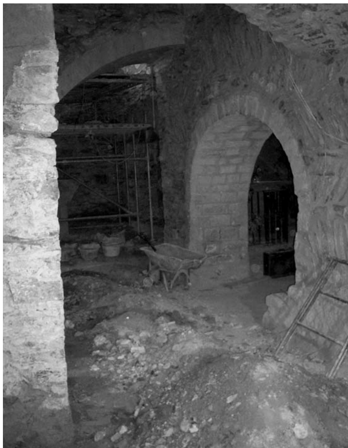
A l'esquerra, treballs de consolidació i millora de l'interior de l'absis de la nau nord. A la dreta, la sala nord sense la paret divisòria.
